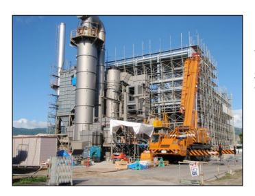
平成25年6月19日 ストーカー炉の据え付けもおわり、 ロータリーキルン炉内部の耐火 材貼り付け工事がはじまってい ます。
