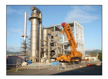
平成25年6月5日 煙突も設置され、焼却施設建屋 の建設作業も進んでいます。
